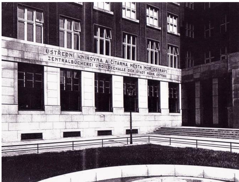
Budova knihovny v Moravské Ostravě (dnešní sídlo České spořitelny), konec 30. let 20. stol.
